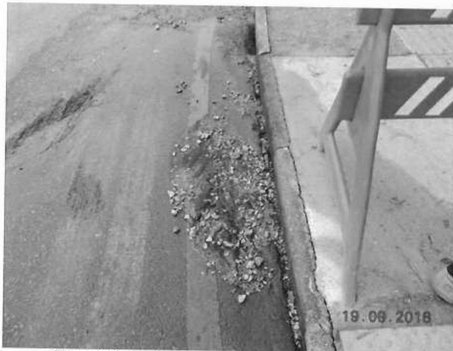
Figura 4: Sinais do vazamento de efluente doméstico na rua.
