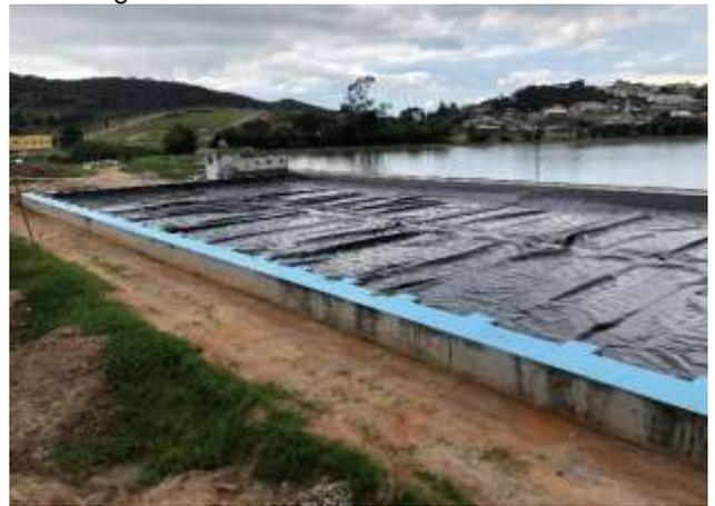
Figura 7 - Cobertura Reator anaeróbio nº 4
