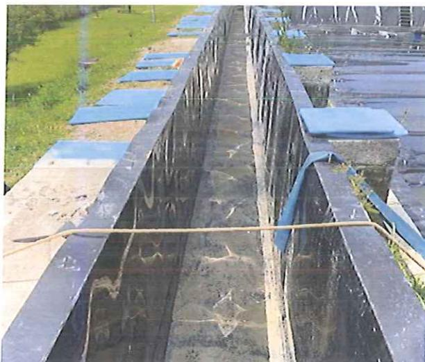
Figura 1 - Revestimento das paredes do canal de distribuição
