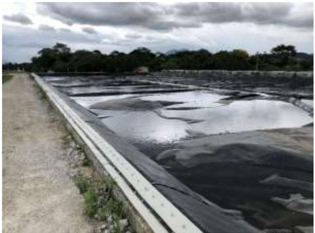
Figura 4 - Cobertura Reator anaeróbio 1
