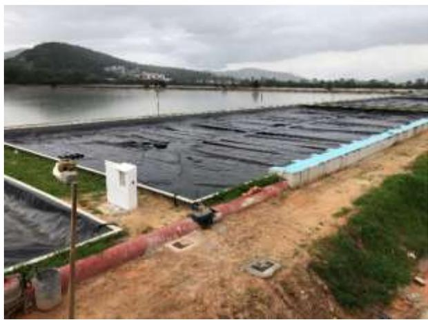
Figura 8 - Reator anaeróbio nº 3
