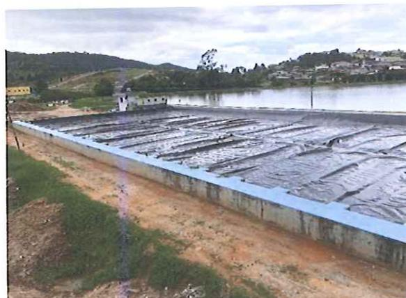
Figura 7 - Cobertura Reator anaeróbio nº 4
