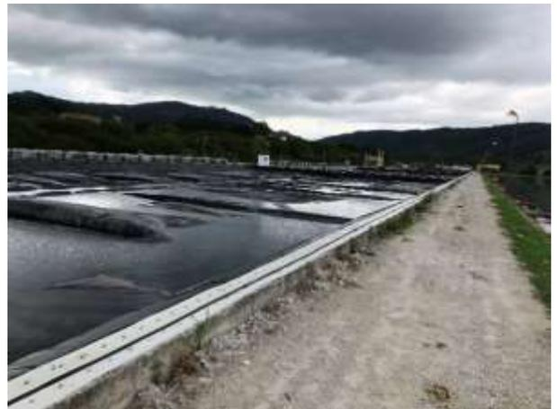
Figura 5 - Cobertura Reator anaeróbio 1
