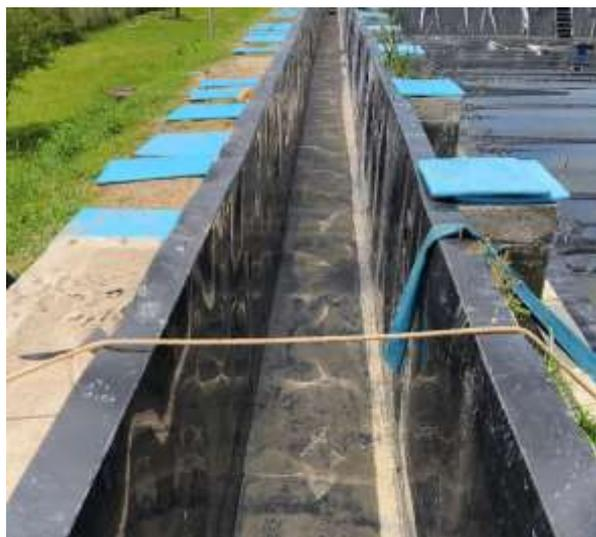
Figura 1 - Revestimento das paredes do canal de distribuição
