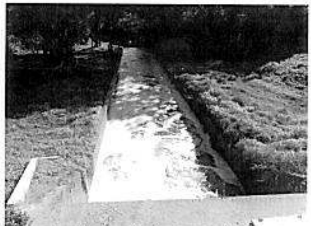
Figura 9. Ponto de lançamento final dos efluentes.
