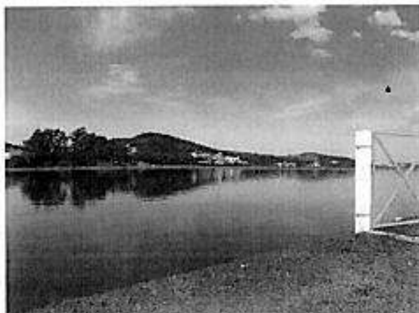
Figura 1. Lagoas de estabilização sem proteção contra queda.
