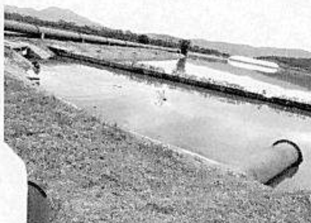
Figura 7: By-pass do sistema de pré-tratamento desativado.
