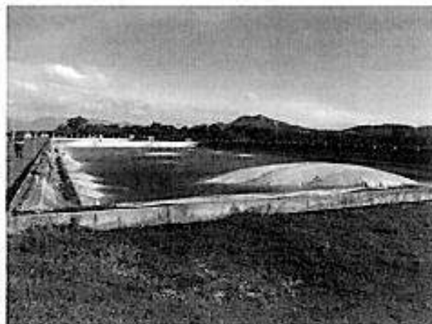
Figura 2. Lonas de retenção de gases ao fundo das lagoas anaeróbias.
