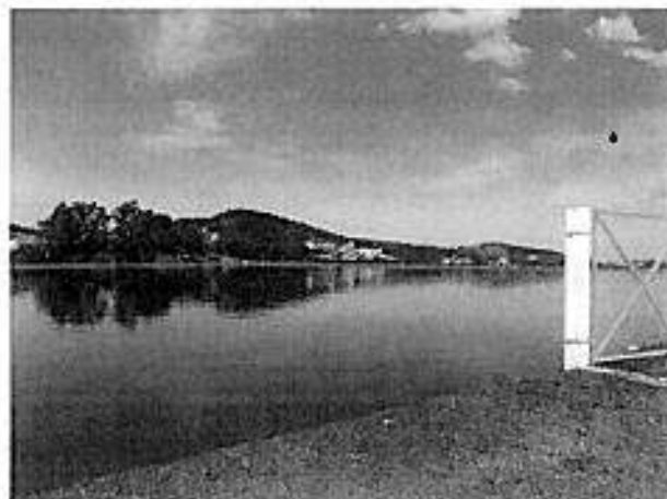
Figura 1. Lagoas de estabilização sem proteção contra queda.
