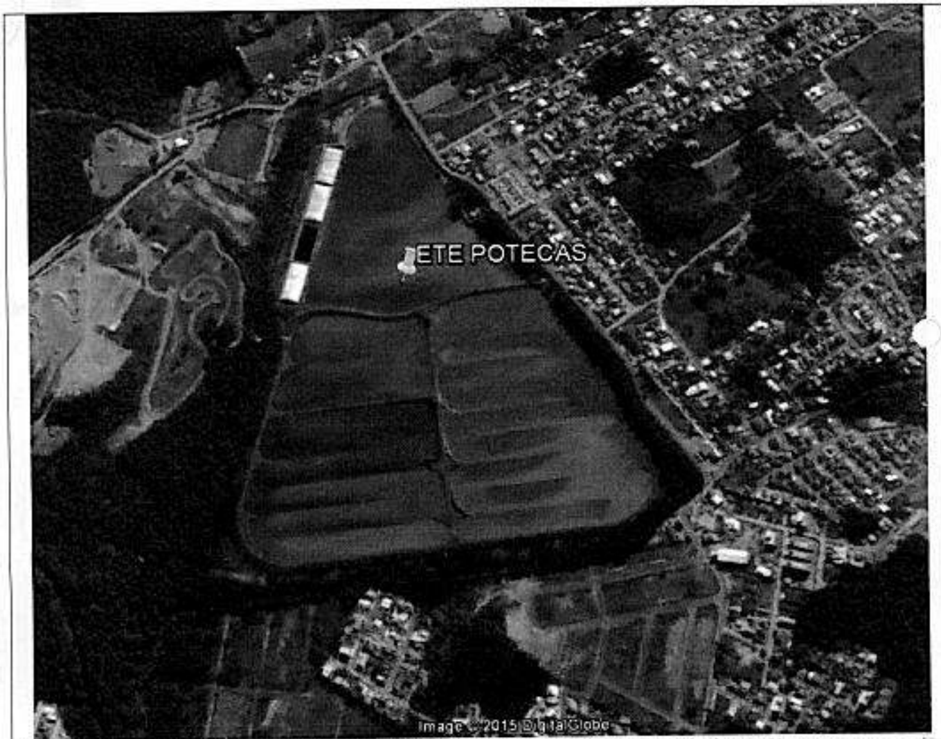
FOTO 01 – Imagem do Google da área da ETE POTECAS e entorno. Data da imagem: 14/05/2014. Observa-se que um reator já estava sem a lona erguida.
