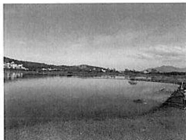
Figura 4. Vista Geral da Estação de Tratamento de Efluentes.
