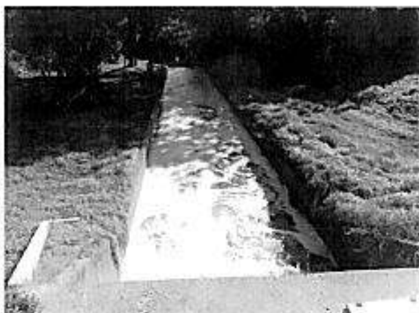
Figura 9. Ponto de lançamento final dos efluentes.
