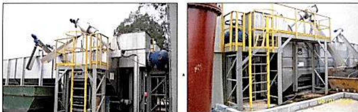
Imagem 3 e 4 – Acessibilidade ao Prê-tratamento - ETE POTECAS. Fonte: Acervo Casan.
