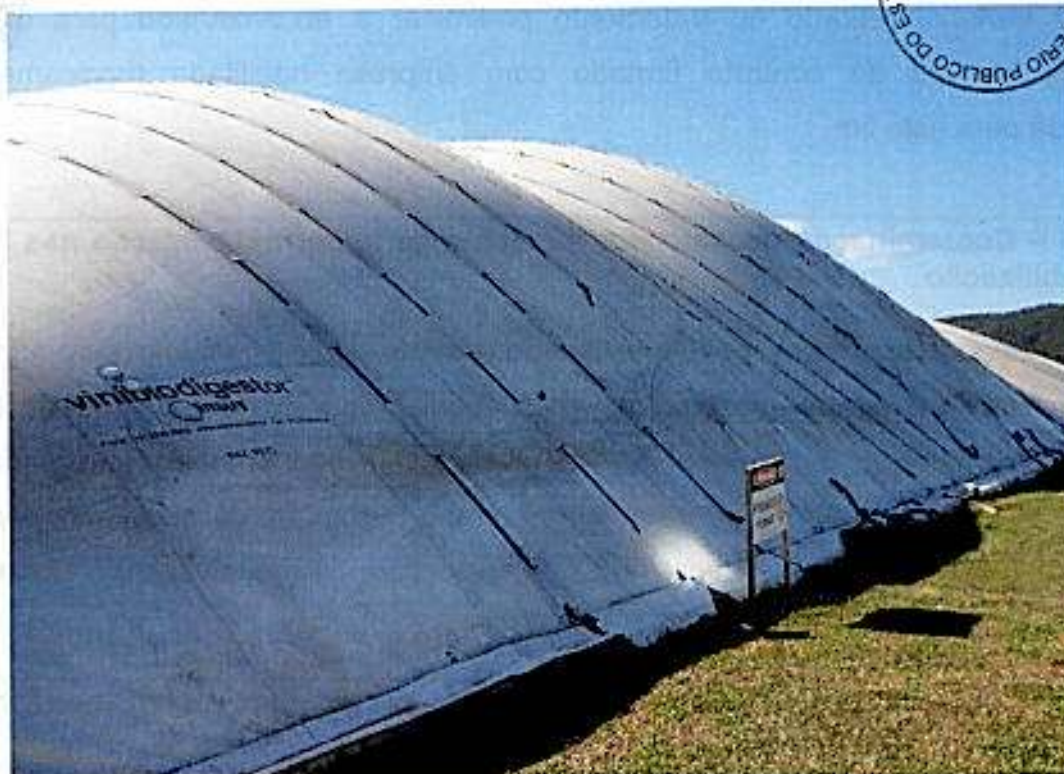
Figura 04 - Reatores Anaeróbios – ETE POTECAS
