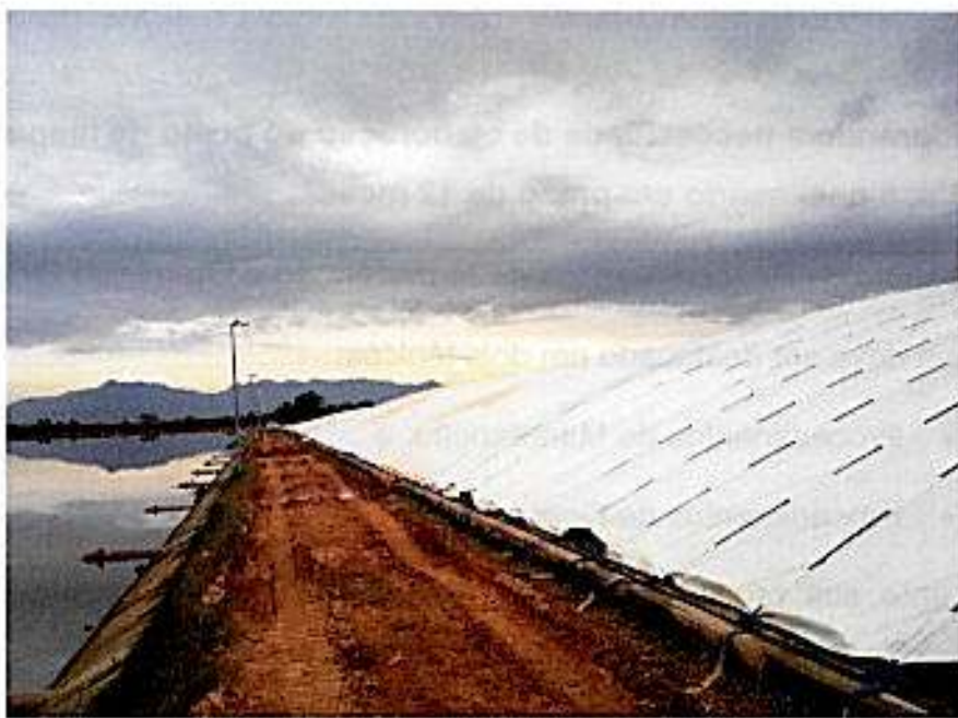
Figura 3 – Vista dos Reatores Anaeróbios (detalhe) - ETE POTECAS. Fonte: Acervo Casan.
