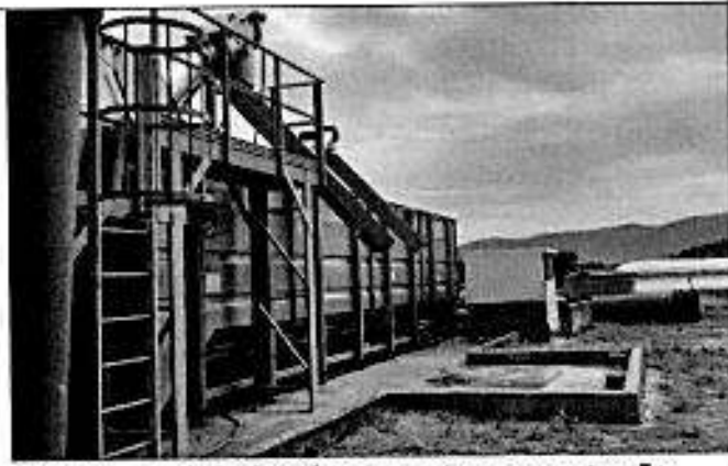
FOTO 03 - Unidade de pré-tratamento em manutenção
