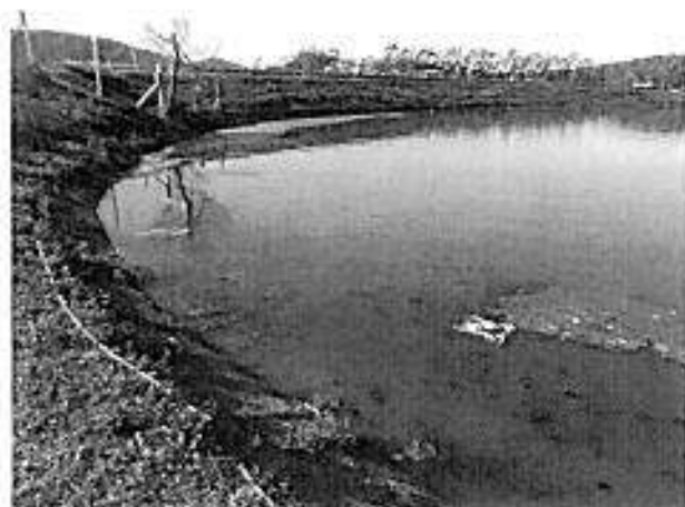
Figura 8. Processo de eutrofização nas lagoas devido ao acúmulo de matéria orgânica na porção final do tratamento.
