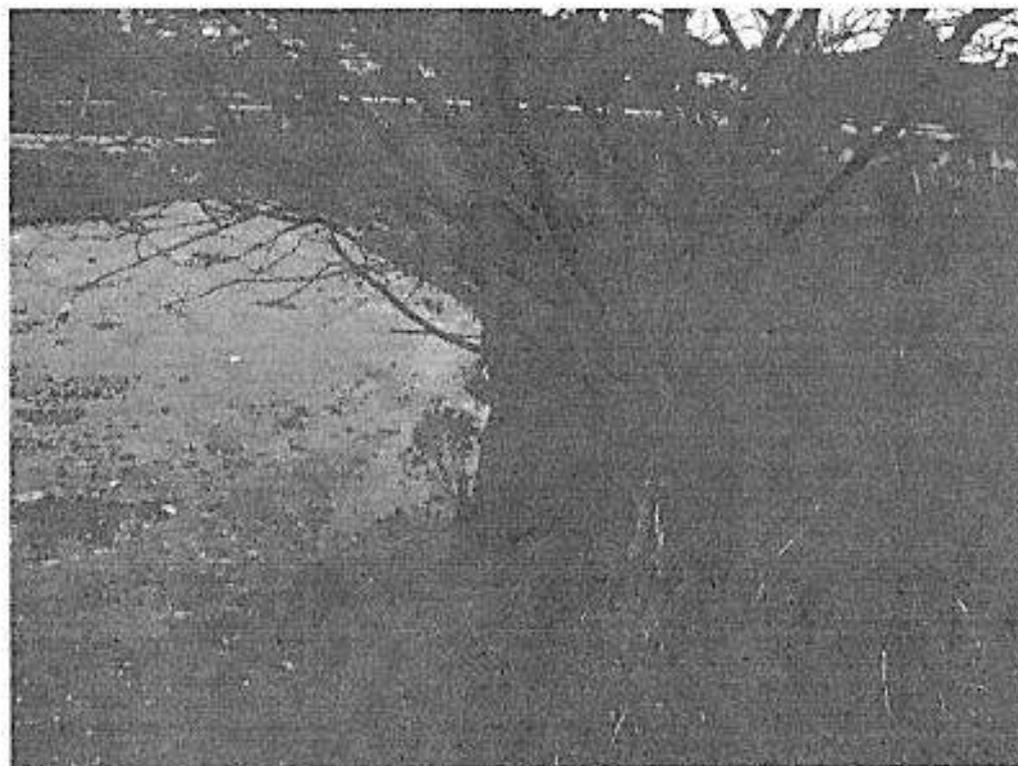
Foto 4 – espinheiro rente ao talude da lagoa. Deverá ter sua retirada o mais breve possível para não causar rachadura do talude e posterior infiltração do efluente no solo.
