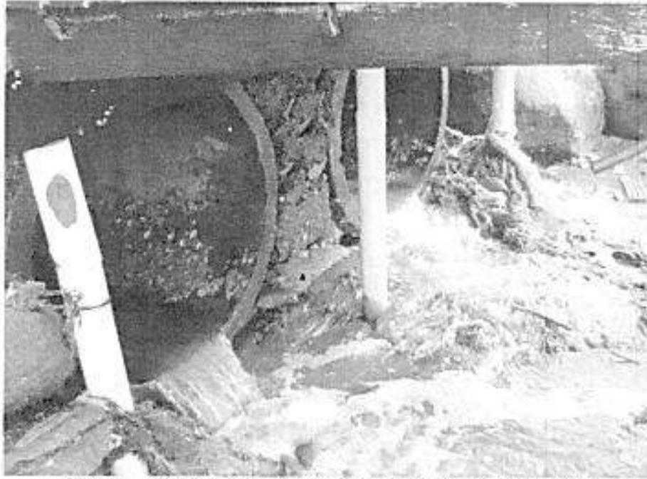
Foto 5 – Vista do extravasor liberando esgoto in natura
