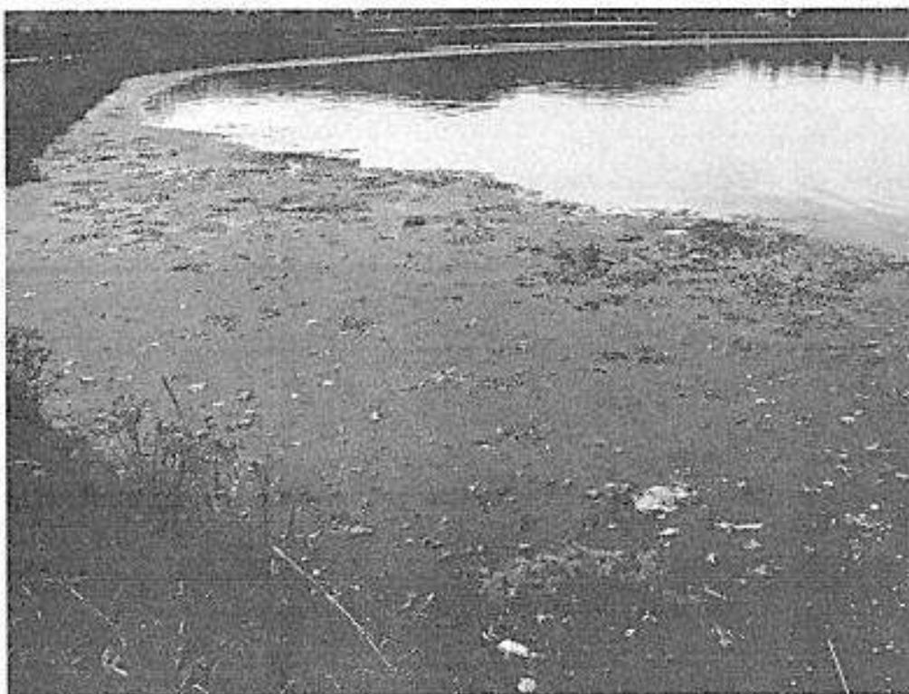
Foto 6 – presença de grande quantidade de lodo desprendido. Retirado do material e enviado a aterro sanitário.
