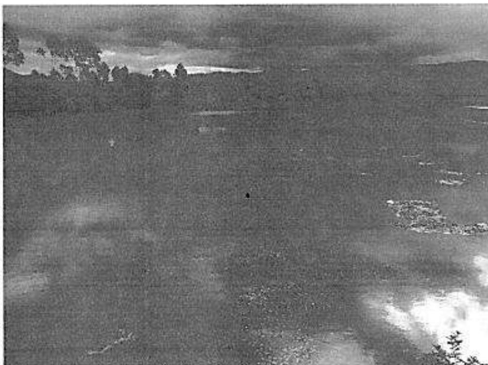
Foto 5 – presença de material sobrenadante, que deverá ser retirado e enviado a aterro sanitário.
