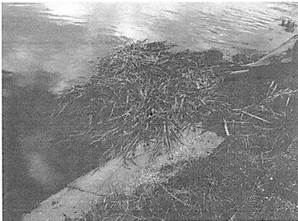
Foto 11 – vista de vegetação retirada e jogada junto a tubulação de distribuição de esgoto. O material não pode ser jogada dentro da lagoa.
