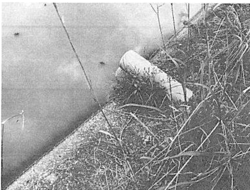
Foto 2 – chegada de esgoto diretamente na segunda lagoa. A tubulação deverá ser retirada e o efluente encaminhado a lagoa anaeróbia.
